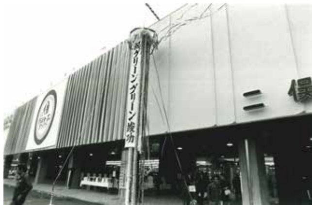
昭和45年(1970)オープンした二俣川グリーングリーン (提供/相鉄グループ)
