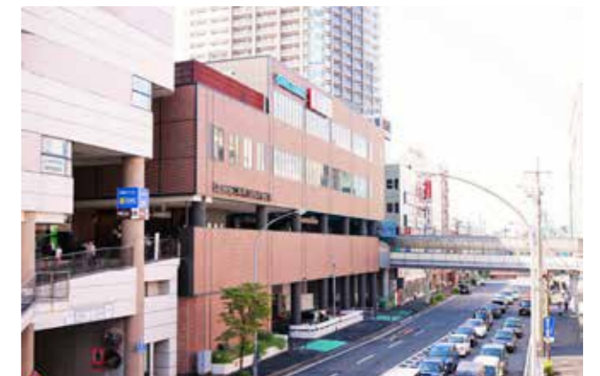
二俣川駅北口 (提供/相鉄グループ)
