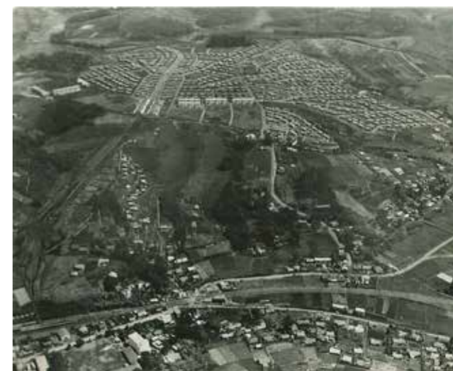
二俣川駅までの道路を建設中の万騎が原団地(昭和30年代) (提供/相鉄グループ)
