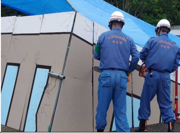
倒壊建物進入口解放及びショアリングの様子
