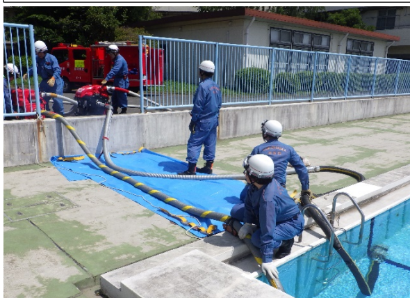
プールからの揚水活動の様子
