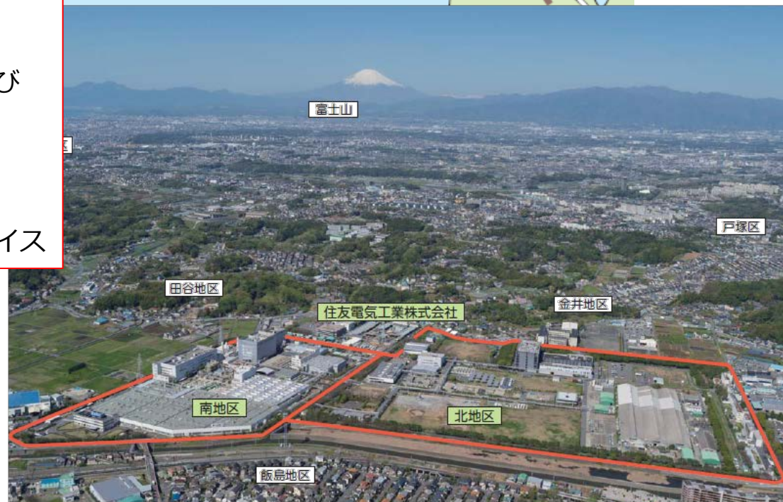
横浜製作所の全景
