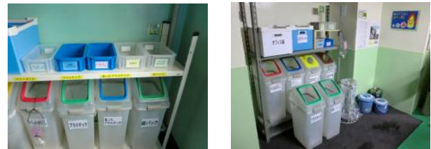
各階に設置された分別ボックス
