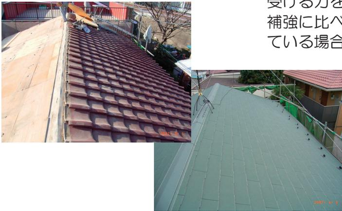
瓦などの重い屋根を軽くすることで地震時に受ける力を小さく出来ます。屋根の軽量化は壁補強に比べ費用がかかるので、屋根が老朽化している場合などに実施するとよいでしょう。
