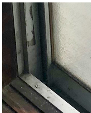
カバー工法施工前
