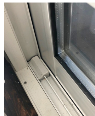
カバー工法施工後
