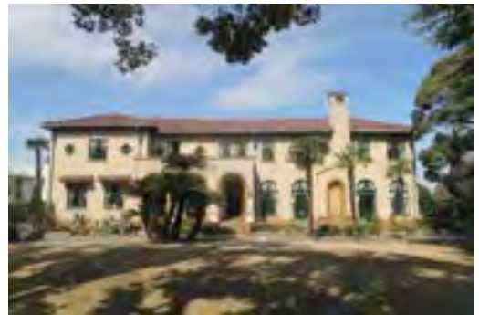
ベーリック・ホール
