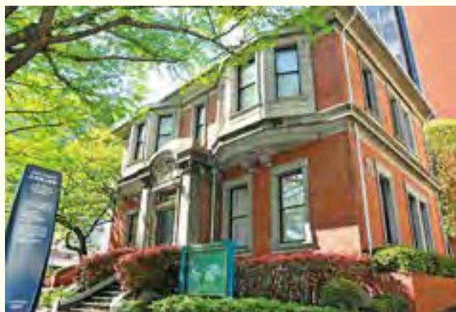
旧英国七番館(戸田平和記念館)…横浜市認定歴史的建造物(平成13年(2001))。震災前から残る希少なレンガの商社建築。昭和50年代、同地での開発計画に合わせ所有者と協議を行い、新築建物をセットバックし当建造物の正面1スパン分を保存する計画となった。
