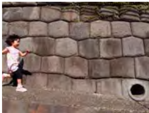
旧平沼専蔵別邸亀甲積擁壁
