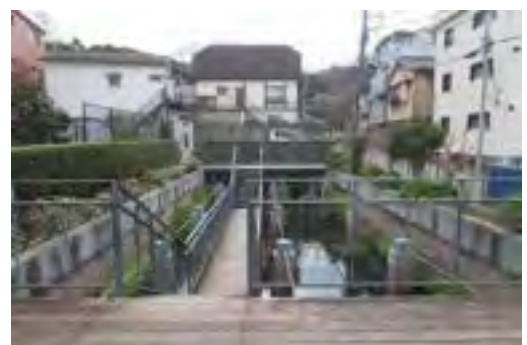
ジュラール水屋敷地下貯水槽
