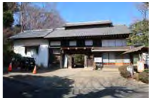
長屋門公園 (写真は旧大岡家長屋門)
