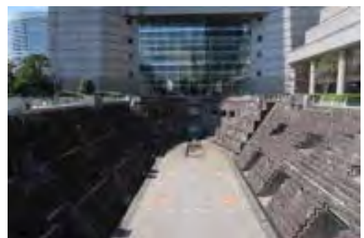
旧横浜船渠株式会社第二号船渠（ドック）
