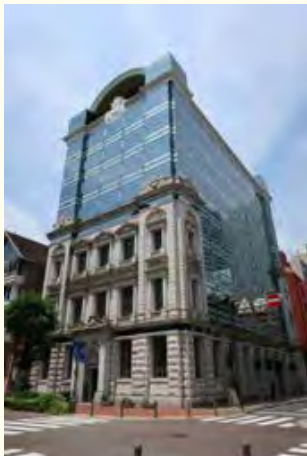
旧川崎銀行横浜支店…横浜市認定歴史的建造物（平成元年（1989））。昭和 60 年代に老朽化により建て替え計画が報じられたが、保存を惜しむ声が大きく、協議により土地の高度利用と保全を両立した。外壁ファサードには当初材の石材が再利用されている。
