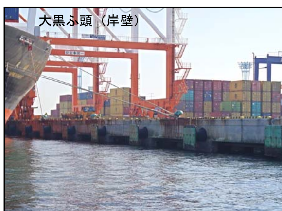
鋼管杭を用いた栈橋（コンテナ船専用岸壁）
