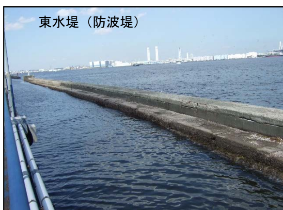
100 年以上経過したコンクリート防波堤 (1896 年竣工)
