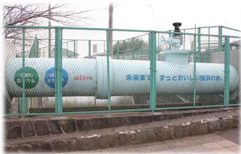
【写真（参考）高山橋水管橋の外観】
