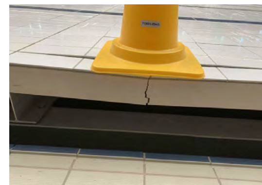
メインプール床のひび割れの状況
