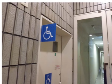
1階多目的トイレに、障がい者 マークを目立つように設置。 わかりづらさを解消した。
