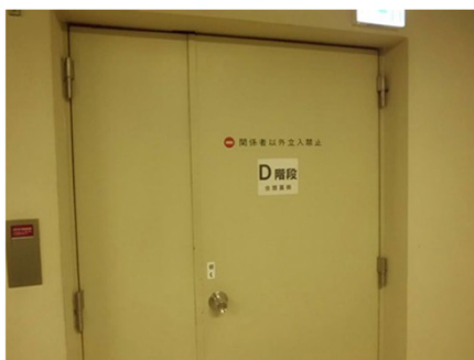
非常階段に通路名をつけました
