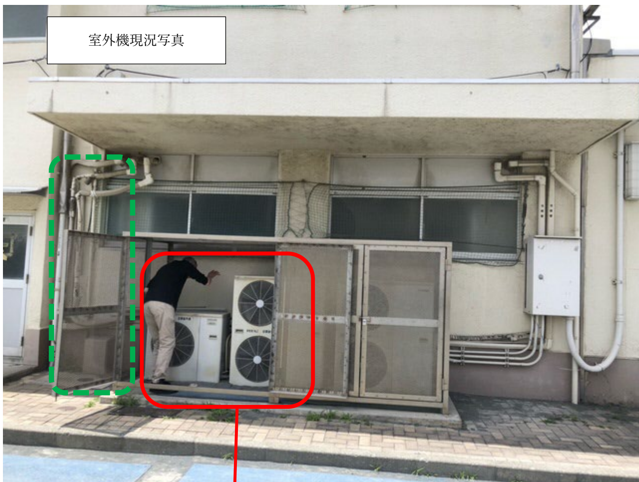
研修室（3基分）2台 外配管：約4m
