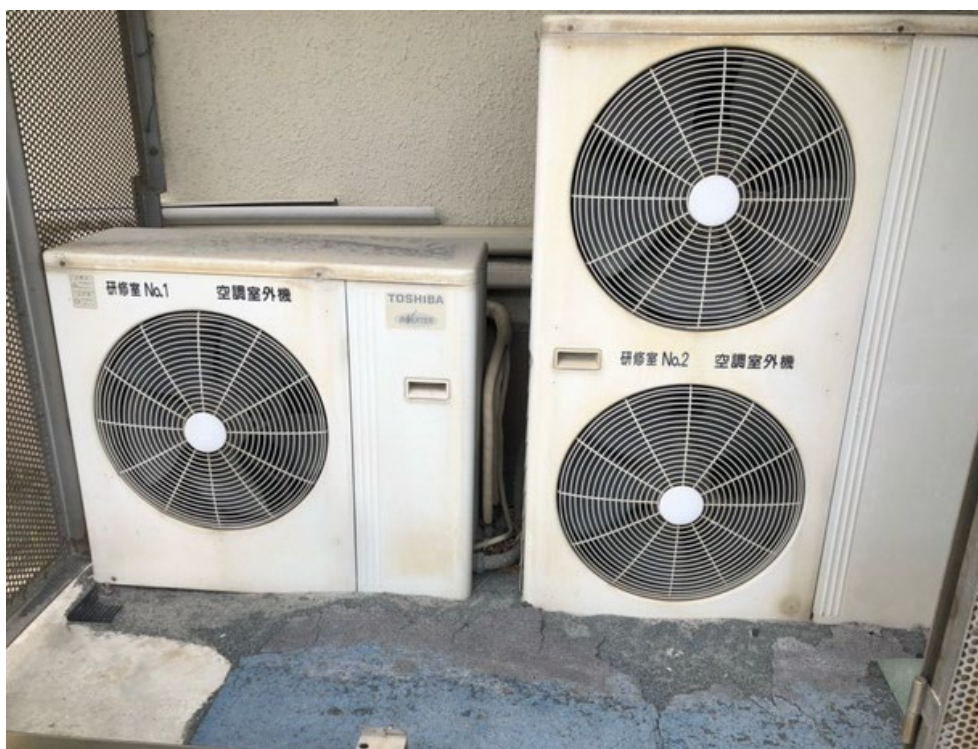
研修室（3基分）2台 外配管：約4m
