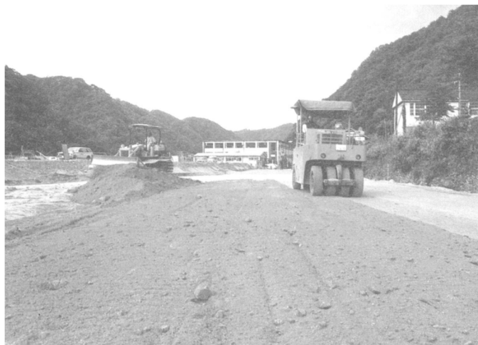
ブルドーザによる敷均し、タイヤローラによる締固め作業
