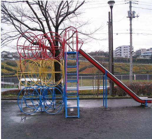
※平成 7 年までの公園緑地標準図集に掲載されていたリングジャングルすべり台は、すべり台の滑り出し口両側に隙間があり、頭部やカバン等の挟みこみの恐れがあること、すべり台の踊り場の安全柵の高さ及び格子間隔が規準を満たしていないこと、ジャングルジム部分に上向き V 字型開口部が多数あり、頭部等の挟みこみの恐れがあることから、平成 20 年度までに撤去した。
