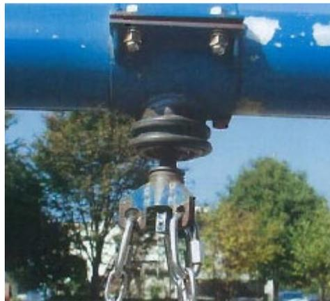
図 2-17 タイヤブランコ吊金具の例
