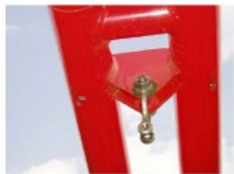
図 2-2 4 吊金具が梁に溶接されている例
