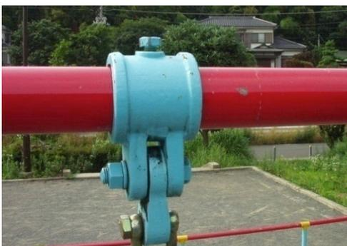
図 2-2 5 吊金具を1本のボルトで梁に押し付けて固定している例
