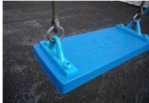
図 2-2 2 吊チェーンと座板の間にリングを入れた例
