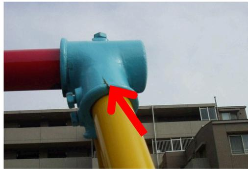
図 2-2 6 梁がボルトで固定されている例
