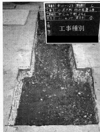
埋め戻し完了状況写真
