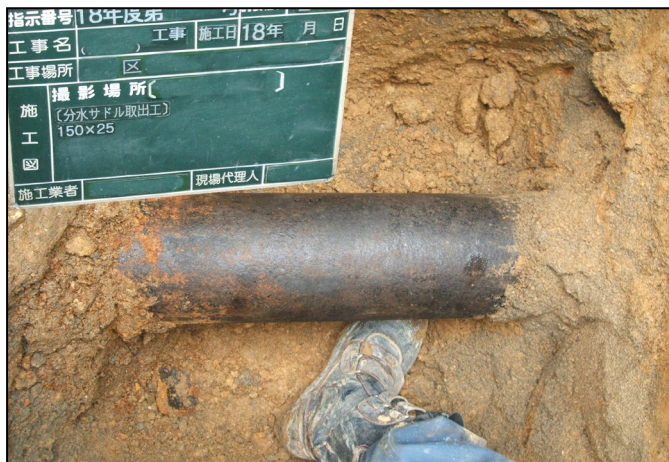
④ 給水管布設状況写真
