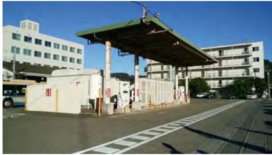
(写真 15)CNG 充てん所
