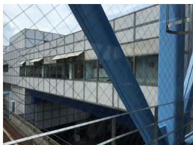
(写真 9) センター南駅外壁タイル
