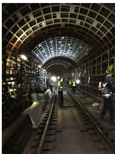
（写真 10）トンネル補修工事
