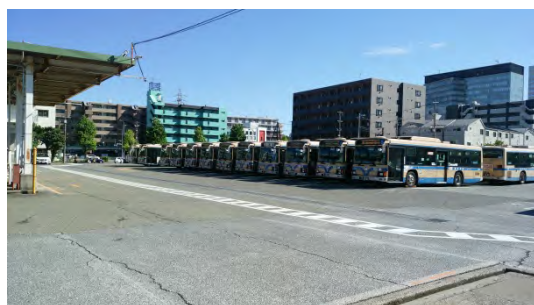
(写真 14) 港北営業所 (全景)
