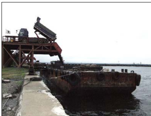
（大黒ふ頭陸上中継所での土砂の積込作業）
