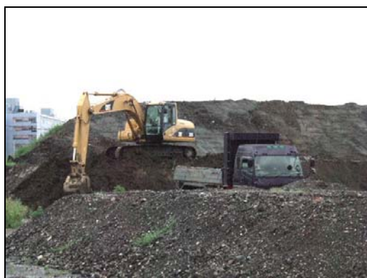
（大黒ふ頭陸上中継所での土砂の仮置作業）
