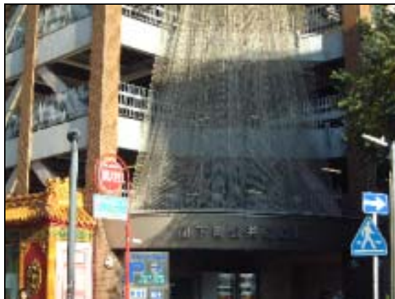
写真 5-8 山下町公共駐車場
