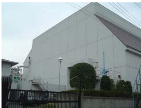
高田ポンプ場外観
