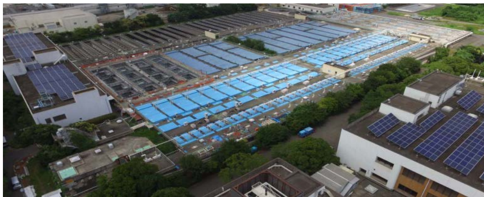
(図) 北部第二水再生センターの外観
