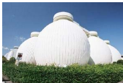
北部汚泥資源化センターの消化タンク
