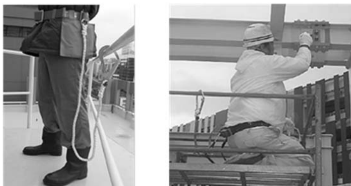
図表2-2-14 墜落制止用器具と使用例
