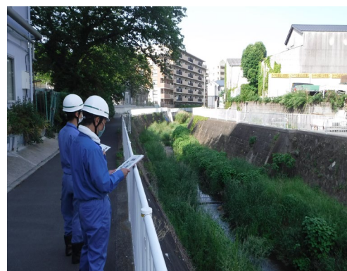
河川管理用通路から点検する様子
