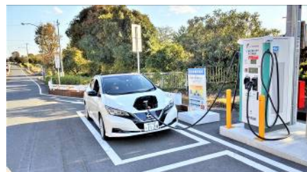
公道充電ステーション (青葉区しらとり台)
