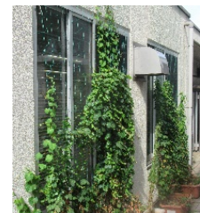
区庁舎での設置
