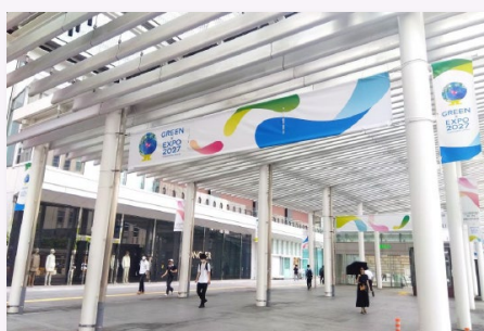
横浜駅西口広場 大屋根
