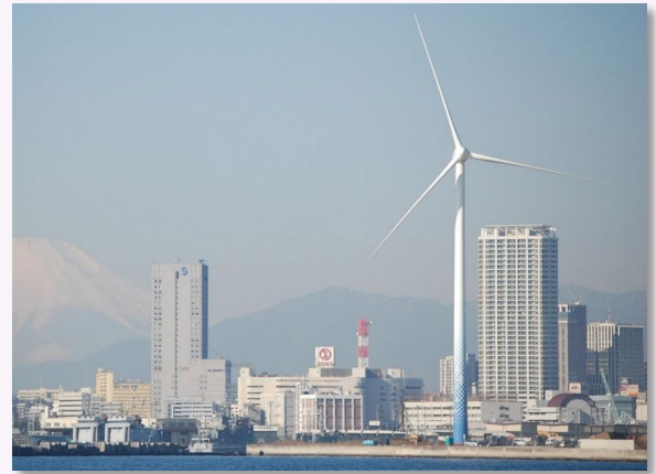
ハマウィング(横浜市風力発電所)
