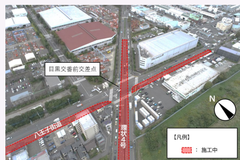
目黒交番前交差点付近 工事状況
