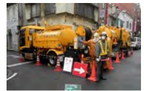
下水道管清掃状況
