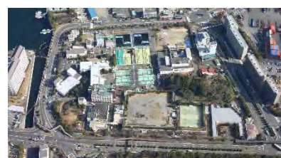
中部水再生センター航空写真
