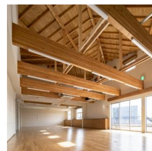
木造で整備した山下地域ケアブラザ
