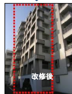
バルコニー外側に耐震フレームを新設 『マンション耐震化マニュアル』より掲載(発行：(一財)日本建築防災協会)
