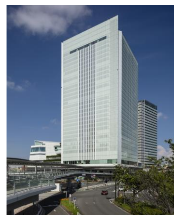
ZEB Ready を達成した市庁舎
