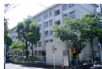
市営矢向住宅 (1975 年建設)
