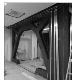
ブレース設置工事 (㈱ケー・アール建築研究所提供)
