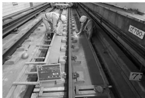
<軌道改良工事>
