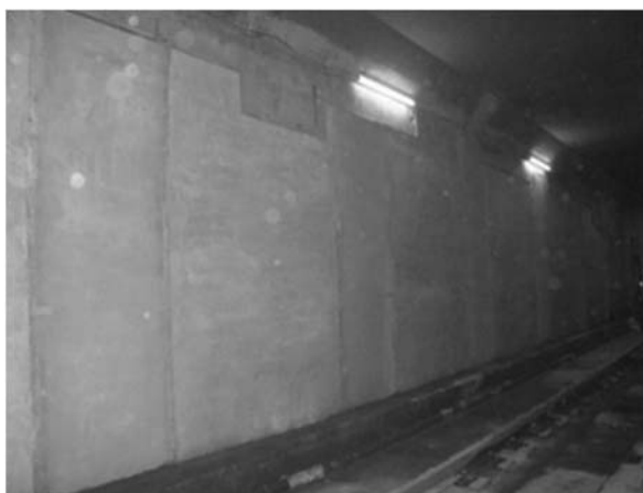
<関内駅構築補修>
