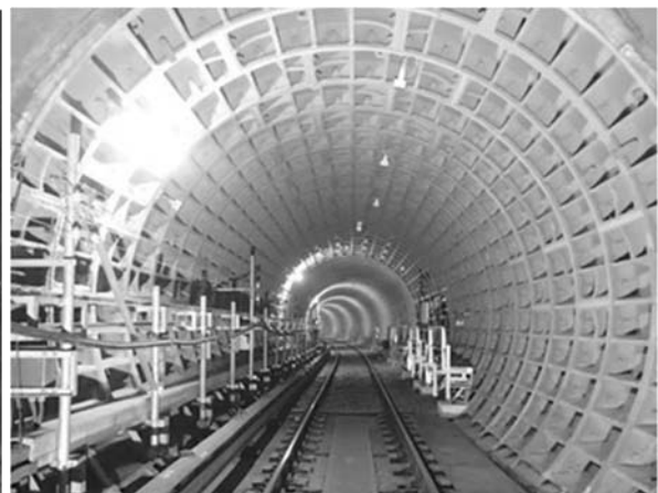
<シールドトンネルの補修>
