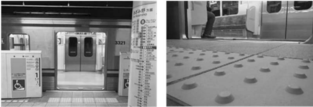
＜新横浜駅 段差・隙間縮小施工箇所＞
