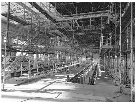
<検修庫増築工事>
