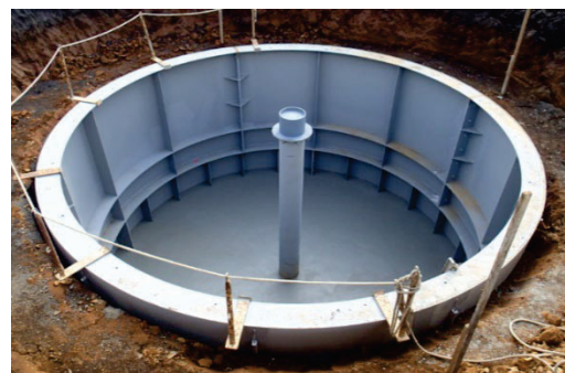
<防火水槽新設工事>
