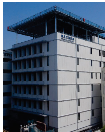
< 消防本部庁舎 >
