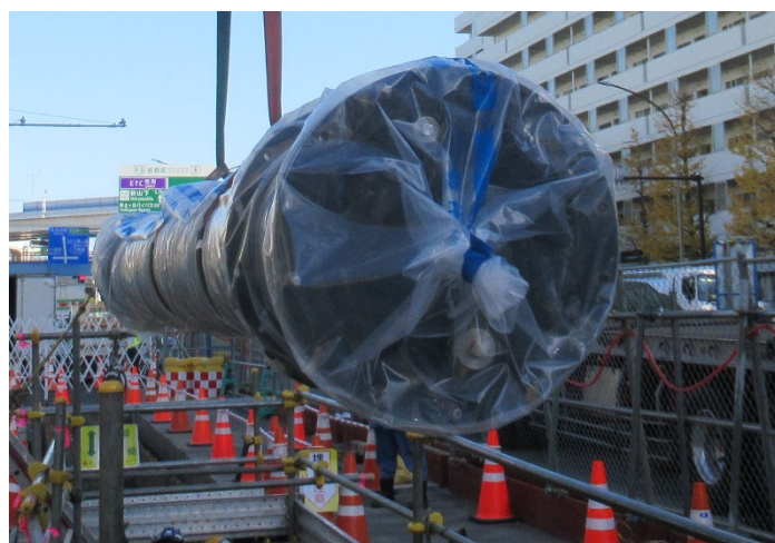
水道管の更新・耐震化
