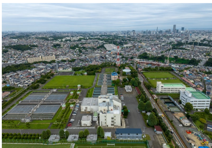
再整備を進める西谷浄水場
