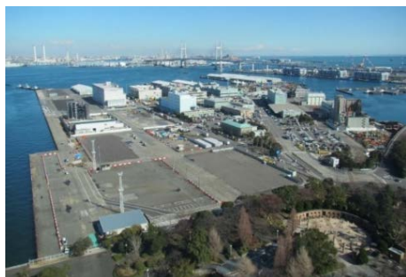
更地化の状況（令和2年1月）
