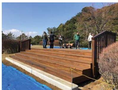
▲整備したウッドデッキの外観
