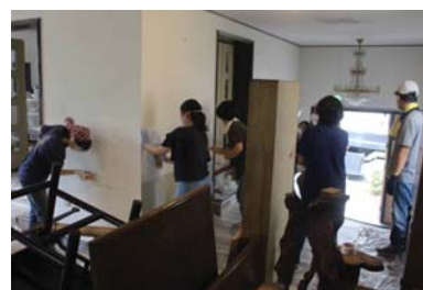
▲内装工事（DIY）の様子
