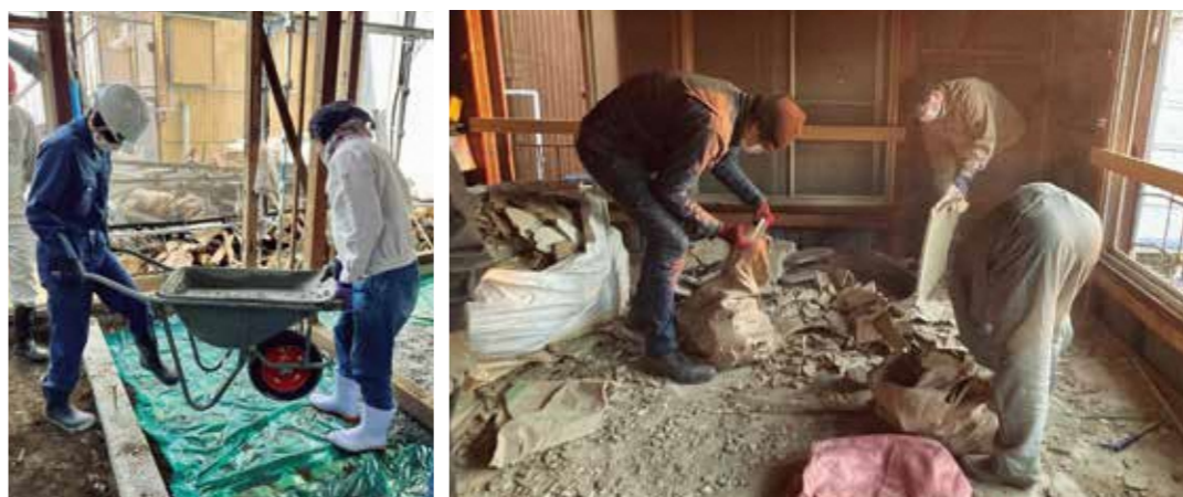
解体からコンクリートの打設、その他内装工事などでもできるところは自ら手がけた
