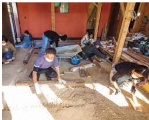
土間打ち作業の様子。左官職人さんに教わりながら住民の手で仕上げた
