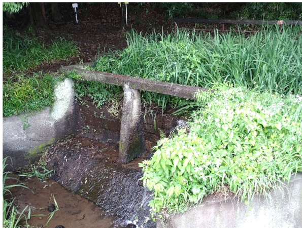
▲ 杉沢堰外観（令和4年）
