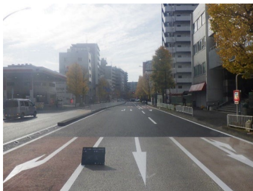
寿町周辺地区の道路整備
