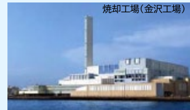
焼却工場(金沢工場)
