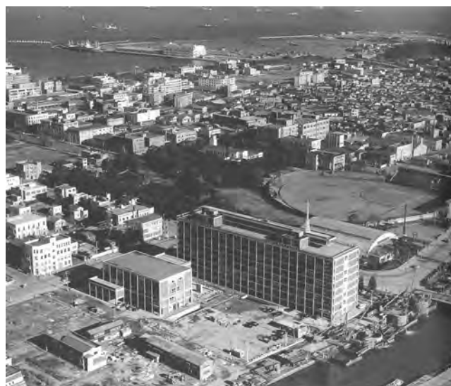
写真3 市庁舎付近 (1959年)
