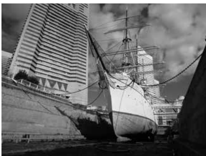
帆船日本丸大規模修繕工事の様子
