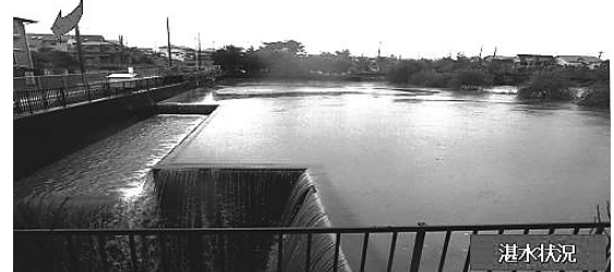
流域貯留浸透事業（青葉区泉田向雨水調整池）
