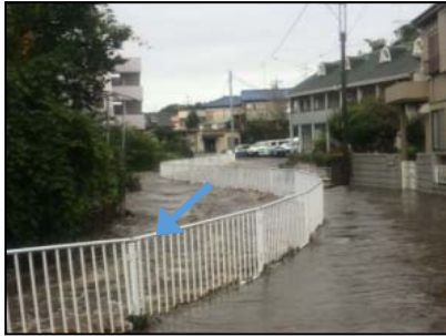
河川の溢水による床上浸水（川井橋）
