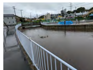
大雨時の巡視状況
