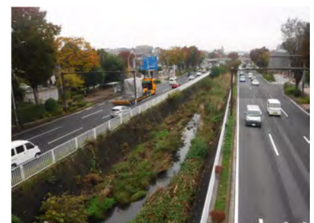
一般護岸（ブロック・石積み等）
