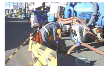
下水道管清掃状況
