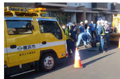
土木事務所作業状況
