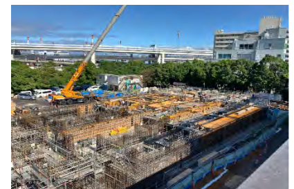
中部水再生センター高速ろ過施設 （築造中）
