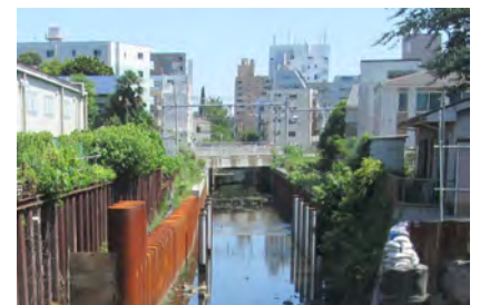
河川改修（護岸整備） (今井川)
