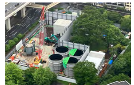
雨水幹線発進立坑築造工 (神奈川公園)
