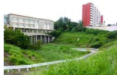
野庭団地第一雨水調整池 （港南区）
