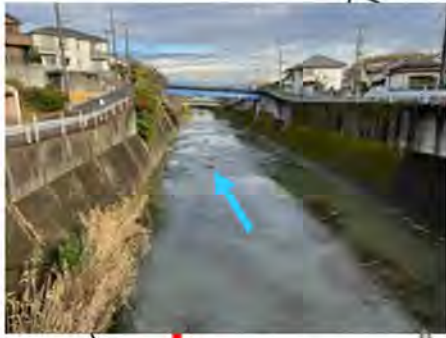
護岸改修、環境整備 (帷子川：旭区上川井町、白根一丁目)
