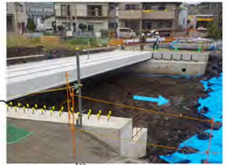
護岸改修、橋梁新設 (帷子川：旭区川井本町)
