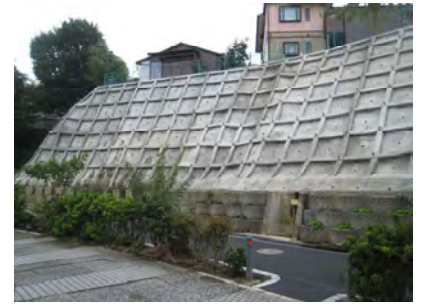
がけ安全対策事業実施箇所 (三ツ沢せせらぎ緑道)
