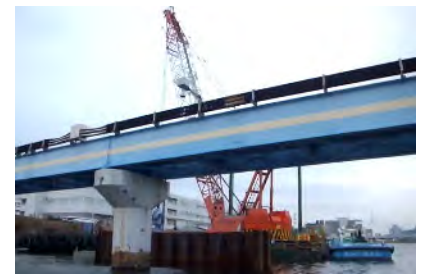
水管橋の耐震化(末吉ポンプ場)
