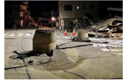
マンホール浮上(輪島市)※
