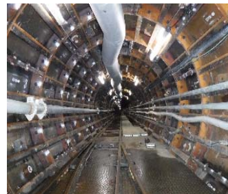
雨水幹線整備状況 (シールド工法)
