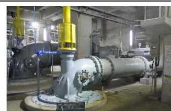
ポンプの再整備（長寿命化）
