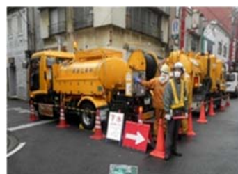
下水道管清掃状況
