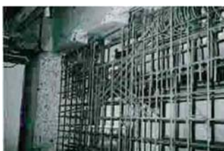
イメージ①水再生センターの鉄筋による耐震補強の状況
