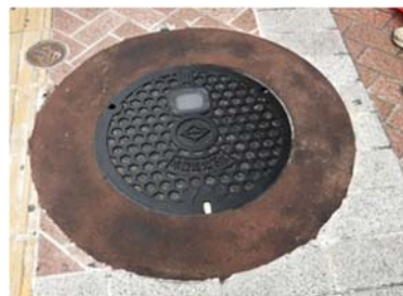
マンホール内計測状況
