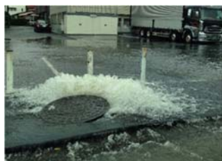
マンホールからの雨水噴出
