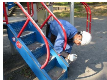
遊具の点検の例
