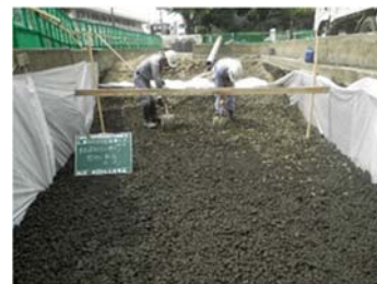
貯留浸透材の設置状況 (中区柏葉公園)
