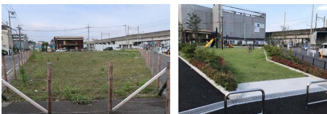
公園の新設整備（左：施工前、右：施工後）
