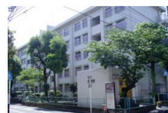
市営矢向住宅 (1975 年建設)
