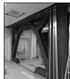
ブレース設置工事 (株)ケー・アール建築研究所提供)
