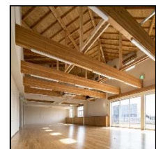
木造で整備した山下地域ケアプラザ
