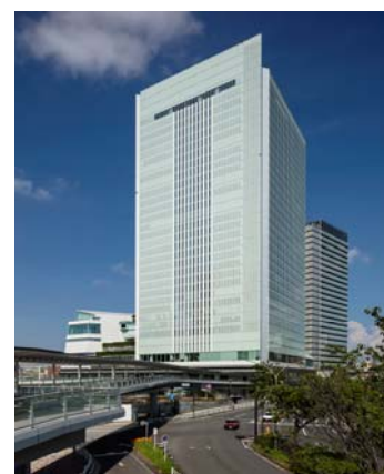
ZEB Ready を達成した市庁舎
