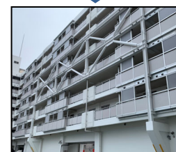
耐震改修補助金利用例
