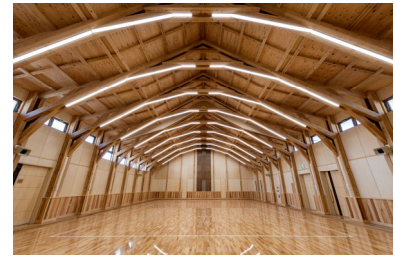
木造で整備した新井中学校武道場
