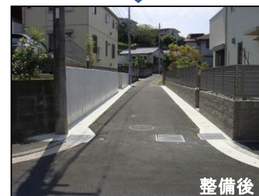
狭あい道路拡幅整備工事
