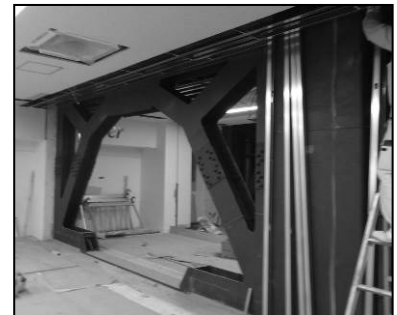
耐震改修事例（ブレース設置工事） ㈱ケー・アール建築研究所 提供
