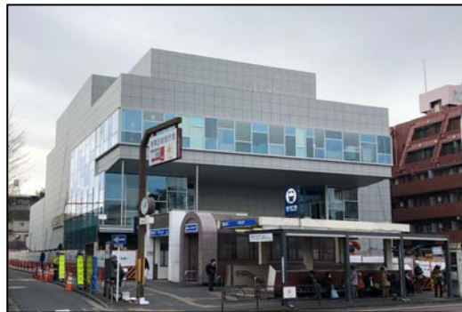
【港南公会堂】 (令和2年度完成)
