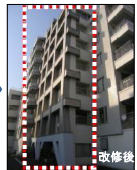
マンション耐震改修事例 (バルコニー外側に耐震フレームを新設) 『マンション耐震化マニュアル』より掲載 (発行：(一財)日本建築防災協会)
