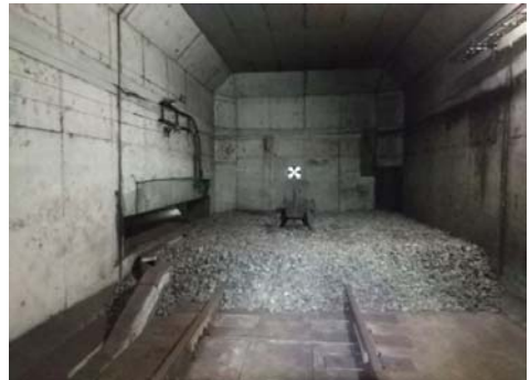
図1 踊場引き込み線終端部
