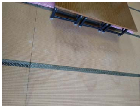
牛久保変電所
