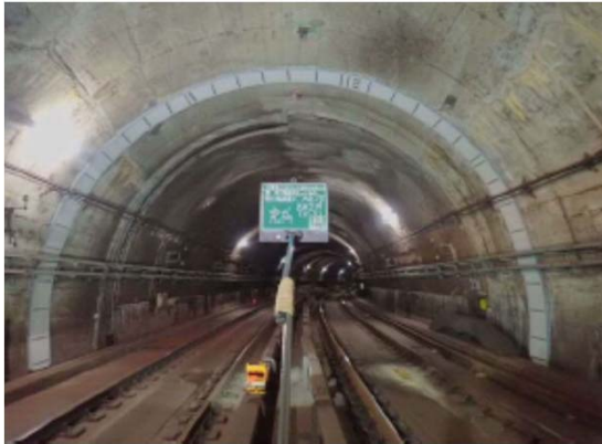
受け樋設置工
