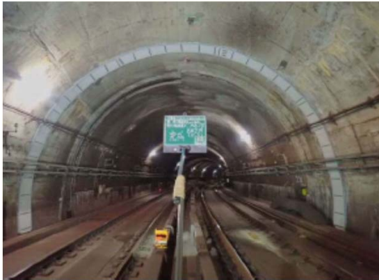
受け樋設置工
