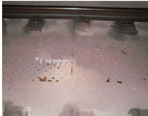
排水溝蓋(アンチスリップ鋼板)
