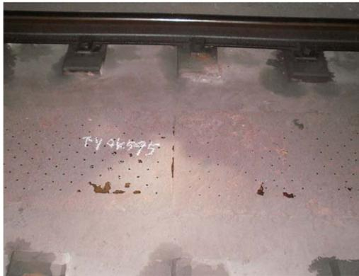
排水溝蓋(アンチスリップ鋼板)
