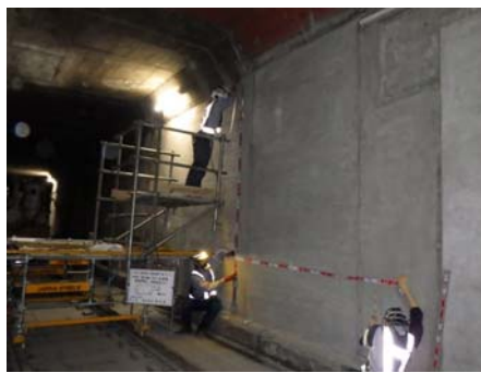
▲コンクリートの修復完了後
