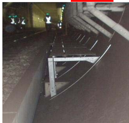
▲作業台設置状況【試験施工】
