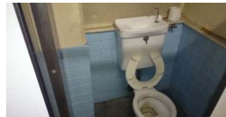
【変電所内トイレ】
