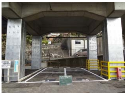
▲ラーメン高架橋RC柱耐震補強実施済み状況
