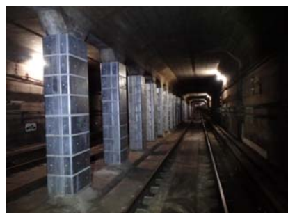
▲開削トンネルRC中柱耐震補強実施済み状況
