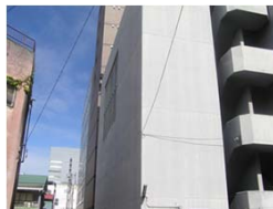
【花咲中間換気所】
