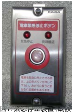
図1 緊急停止装置(旧設)
