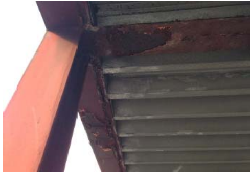
【上屋の梁部分】
