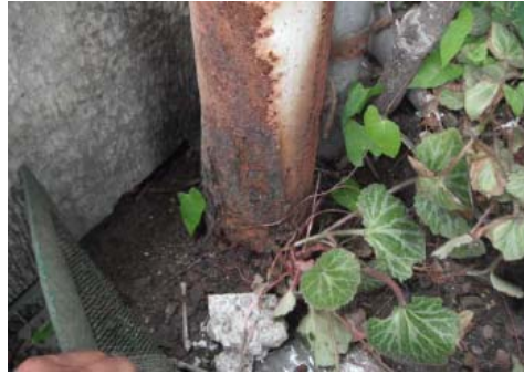
【上屋の支柱部分】
