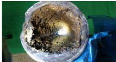
【閉塞した汚水配管内部】
