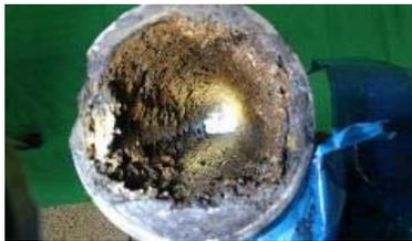
【閉塞した污水配管内部】
